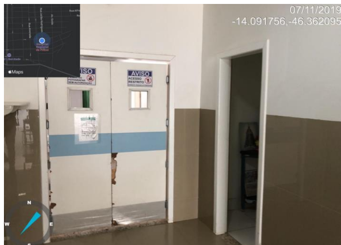
ACESSO ÁREA DE INTERVENÇÃO 2
