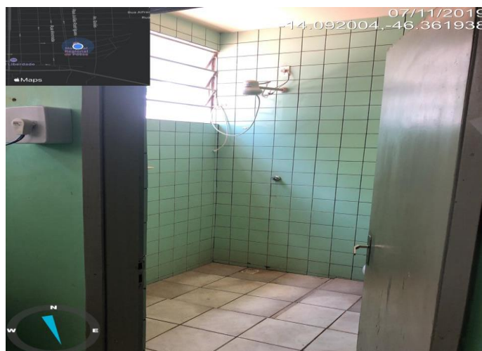
BANHEIRO DESCANSO DE FUNCIONÁRIOS
