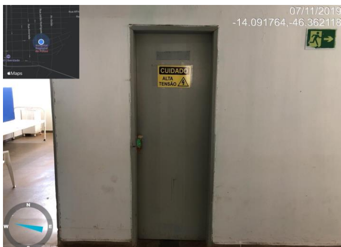
ACESSO QUADRO DE COMANDOS
